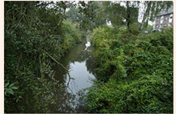
Ein Gutachten zur Entschlammung des Nordkanals schafft Klarheit.
